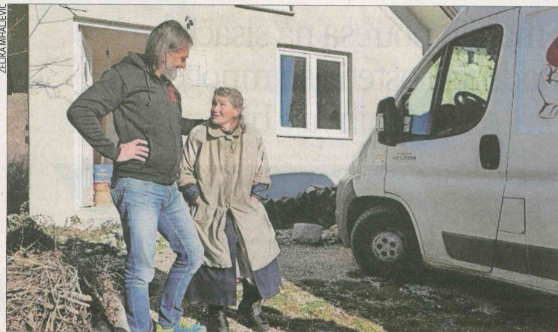
Toša s Nedom Perković: Zahvaljujući dobrim ljudima i fra Đoki, dobila je krov nad glavom, sagradili joj kućicu
